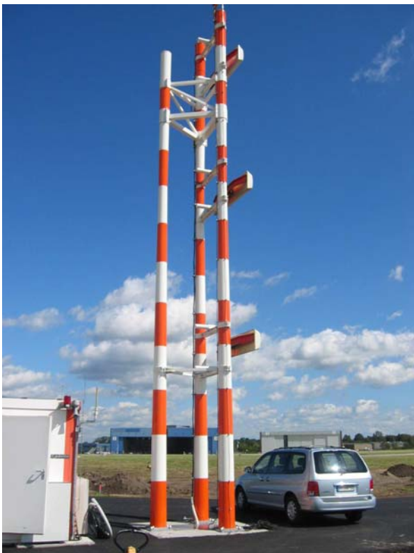
Abb.3: Gleitwegsender-Antenne
